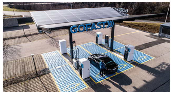
Fig. 41 : Installation de bornes de recharge rapide avec un aménagement similaire à celui des stations-service.
