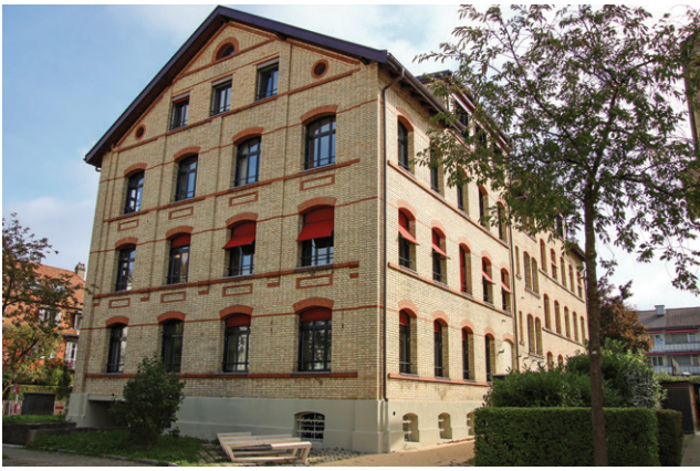
Ancien bâtiment Ackeretstrasse in Winterthur (source: Invisia)
