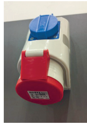
Fig. 45 : Prise CEE munie de connecteur incorporé T23 (par exemple pour scooters électriques, aspirateurs, etc.) : alternative utile pour les compteurs en amont du point de contact et non dans la colonne de recharge.
