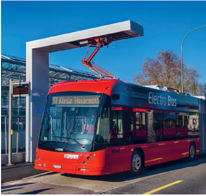
Fig. 15 : La recharge occasionnelle se fait généralement lors des arrêts et se caractérise par une puissance élevée et une connexion au pantographe (source : luzernerzeitung.ch, eBus Zug).
