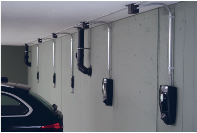
Fig. 50 : Solution avec plaque arrière de fixation (source : NovaVolt).
