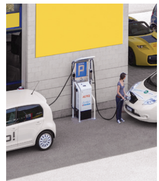
Fig. 37 : Borne de recharge rapide installée en dehors de la place de recharge.
