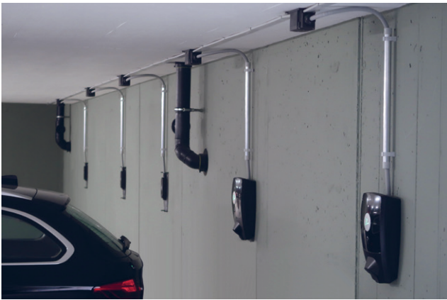
Abb. 50: Lösung mit Befestigungsplatte (Quelle: NovaVolt).
