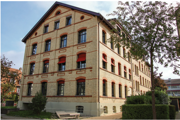
Altbau Ackeretstrasse in Winterthur (Quelle: Invisia)
