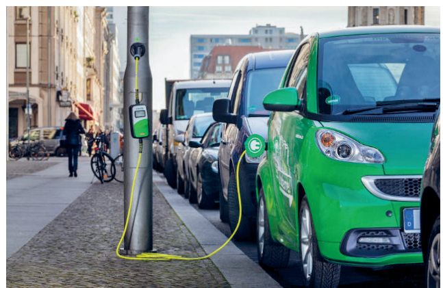
Abb. 79: Zähler im Kabel integriert (Ubitricity).
