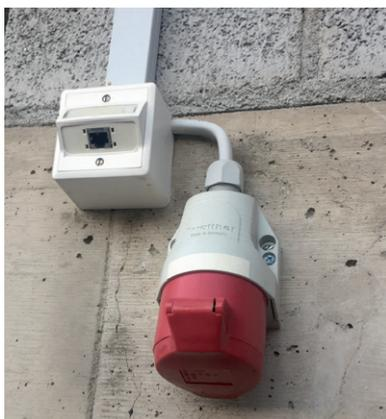
**Fig. 47:** Punto di allacciamento per una futura stazione di ricarica con presa CEE e connessione LAN. Soluzione ottimale per l’inserimento della stazione di ricarica in un sistema di gestione del carico e/o di accesso e pagamento.
