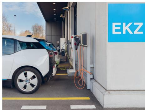
**Fig. 36:** Stazione per ricarica normale/accelerata installata all'esterno dello stalli (fonte: EKZ).
