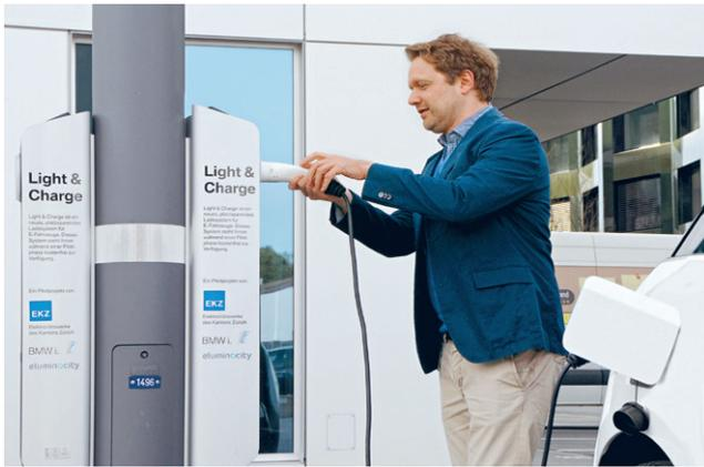
**Fig. 5:** Le stazioni lampione sono fissate al palo d'illuminazione (fonte: EKZ).
